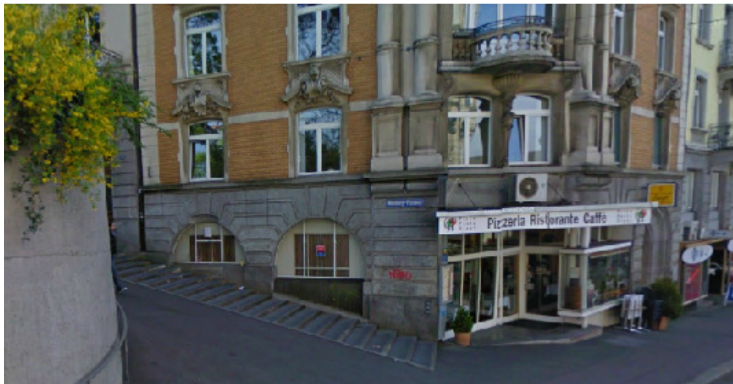
Rampe und Treppe. Weinberg-Fußweg, 8001 Zürich
